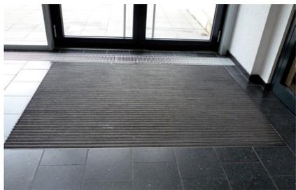
Abb. 5: Schmutzfangmatte (Schmutzschleuse) bodengleich verlegt
