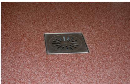
Abb. 4: Bodengleich verlegter Ablauf
