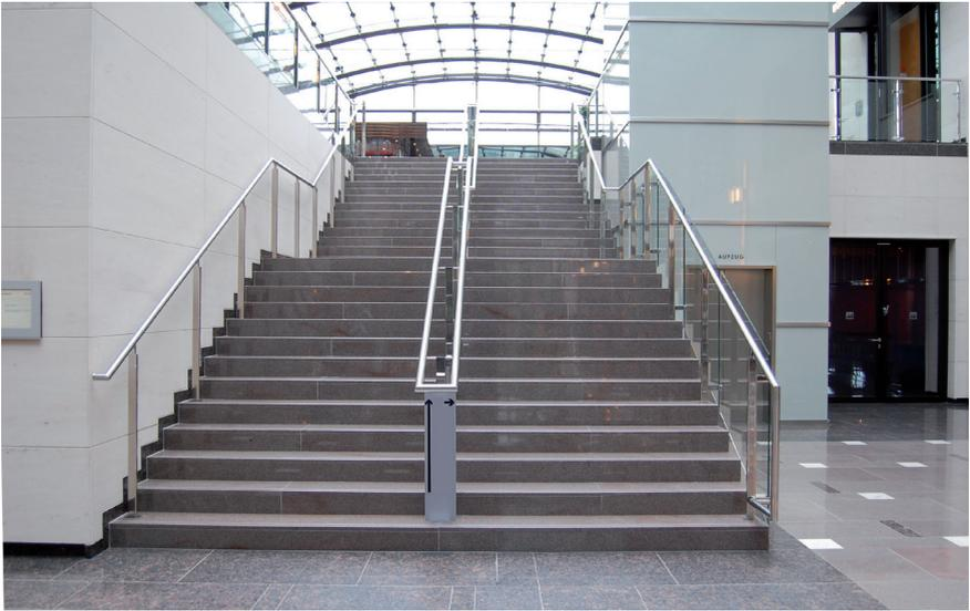
Abb. 7: Treppe mit zusätzlichem Zwischenhandlauf
