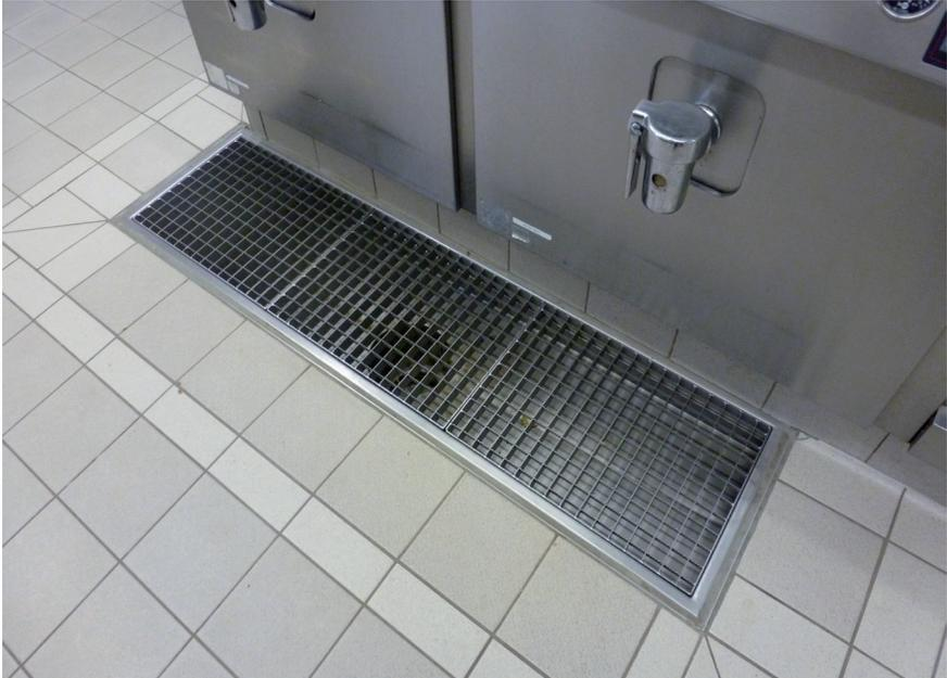
Abb. 3: Abdeckgitter oder -roste müssen die gleiche Rutschhemmung aufweisen wie die angrenzenden Fußböden
