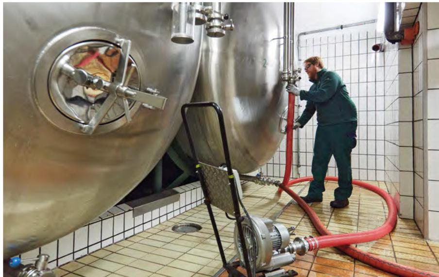
Der Heinzelmann saugt Raumluft an und bläst sie über die Spritzkopfleitung (oben) ins Tankinnere. Über den Auslauf am Tankboden (unten) wird das Luft-CO<sub>2</sub>-Gemisch in die angeschlossene Gelägerleitung gedrückt.
