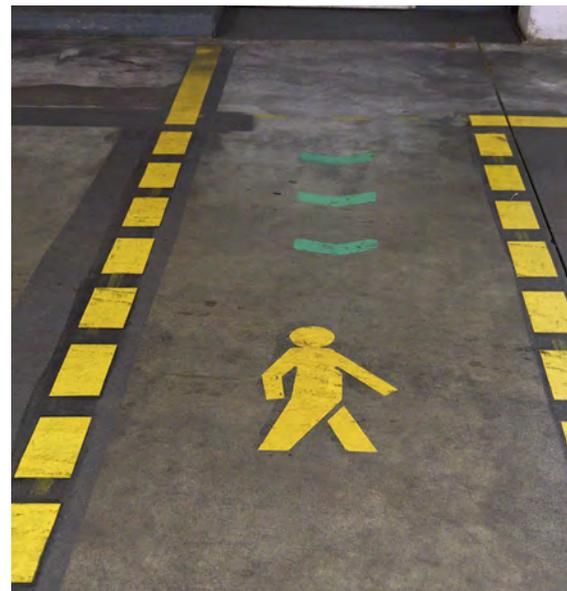
**Bild 7:** Gehweg im Innenbereich ohne Staplerverkehr
