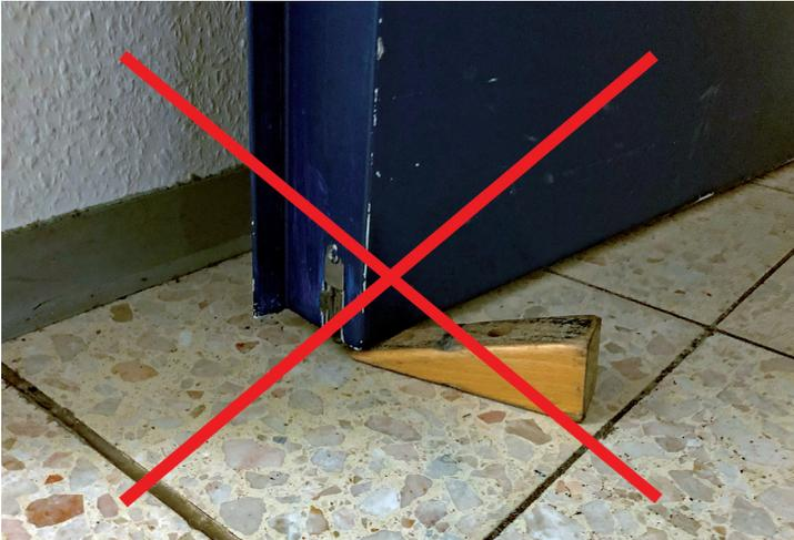
Abb. 13: Verbotenes Verkeilen einer Brandschutztür
