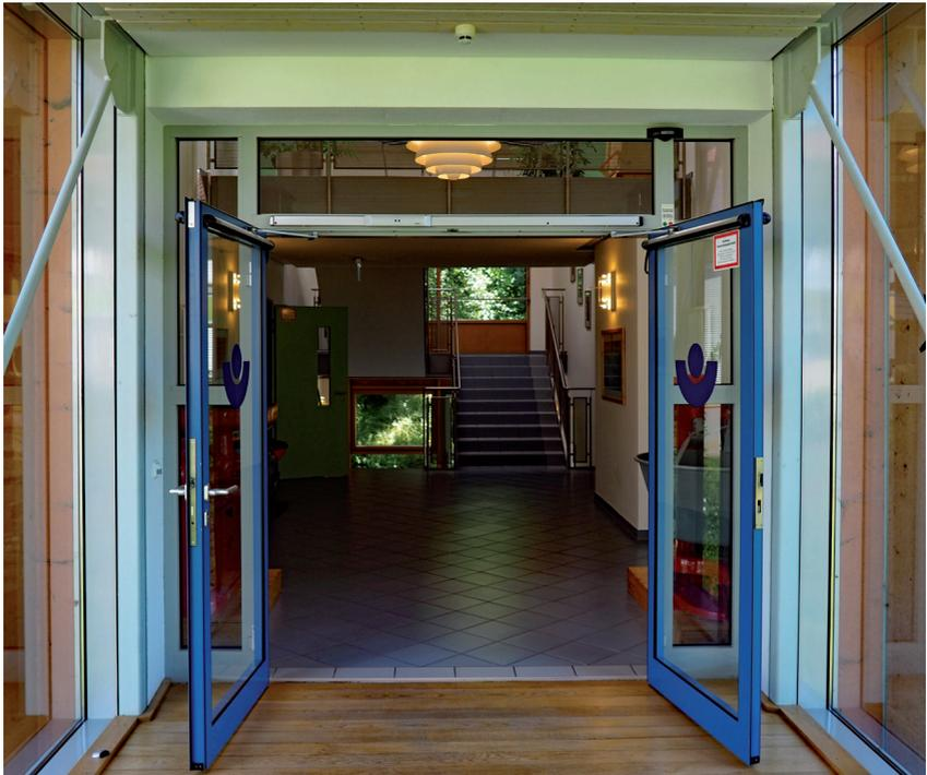
Abb. 12: Zweiflügelige Feuerschutztür mit Rauchsensor und automatischer Türschließung.
