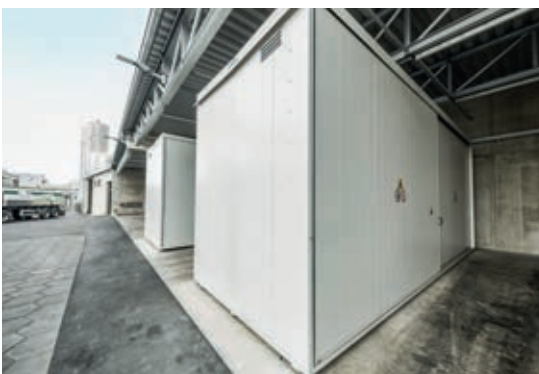
Mehrere einzelne Container für brennbare, lösemittelhaltige Stoffe sowie für andere Stoffe und Gemische
