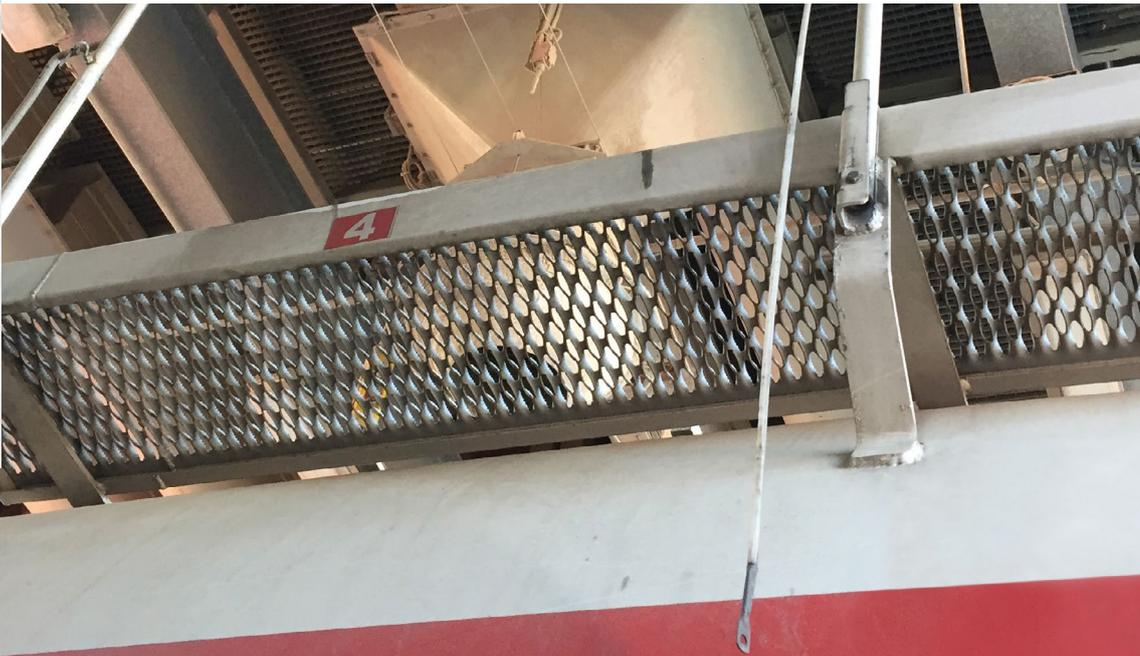
Das Stahlseil war als Knieleiste des aufgestellten Lkw-Geländers angebracht. Es löste sich durch die Wucht des Körperaufpralls aus seiner Befestigung.
