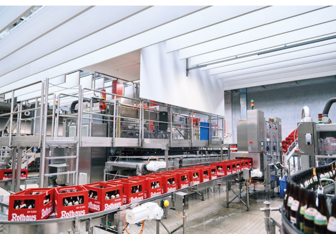
Bild 5: Akustikdecke und -schürze am Entlader der Sortieranlage
