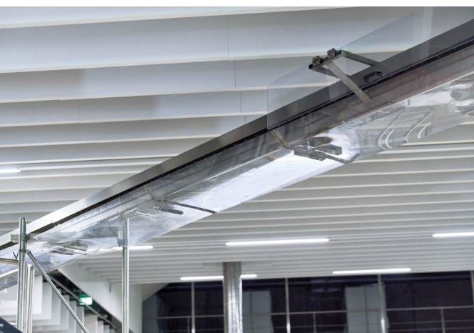
Bild 3: Eingehautes Kronkorken- transportband
