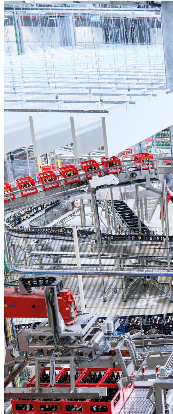
Bild 1: Sortieranlage mit Akustikdecke im Kernbereich
