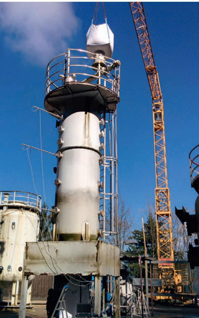
Messungen im Kleinsilo der BGN-Versuchsanlage in Kappelrodeck
