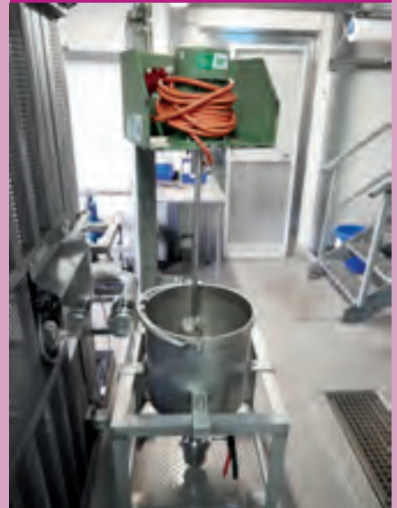
Vorher: Unvollständige Maschine ohne Schutzeinrichtung.
