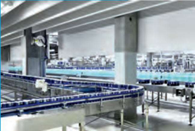
Bild 1: Schürzen schirmen die Hochleistungs-Dosenlinie ab, so dass im Hallenbereich davor fast 5.000 m 2 Akustikdecke eingespart werden konnten.
