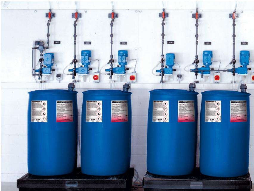
Abb. 2: Lagerung von Kunststoffgebinden auf geeigneten Auffangwannen, Calvatis GmbH
