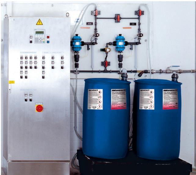
Abb. 4: Automatische Dosier- und Mischstation mit fester Verrohrung, Calvatis GmbH
