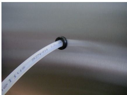
Abb. 7: Geschützte Verlegung der Gasleitung
