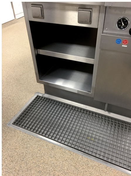
Abb. 2: Beispiel für eine tritt- und kippstichere, belastbare und bodengleiche Ablauföffnung
