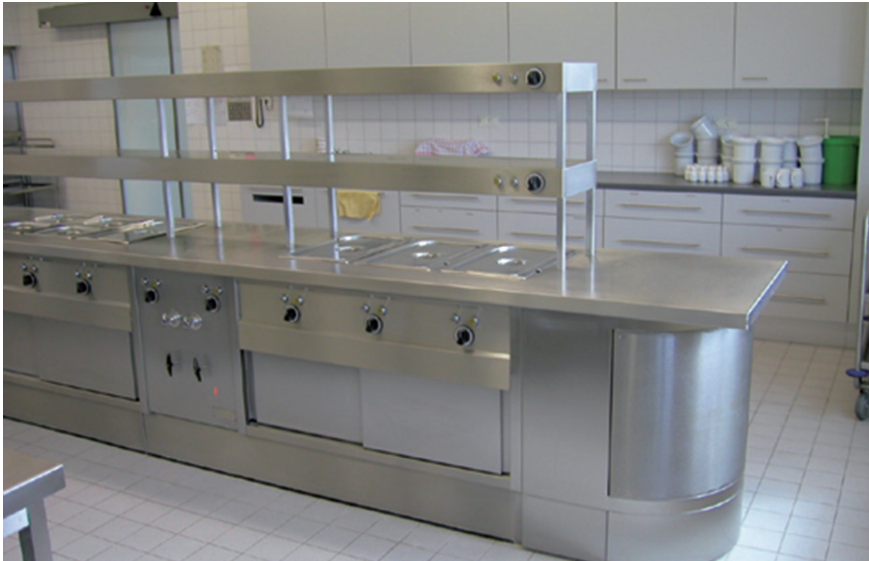
Abb. 5: Quellluftauslass in den Küchenblock integriert (Stirnseite)
