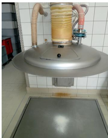
Abb. 5: Absauganlage Silowaage
