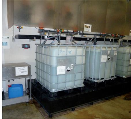
Abb. 5: Spritzschutz (Vorhang) über Flanschen und Pumpen
