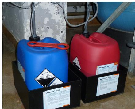
Abb. 4: Dosierung über Sauglanze
