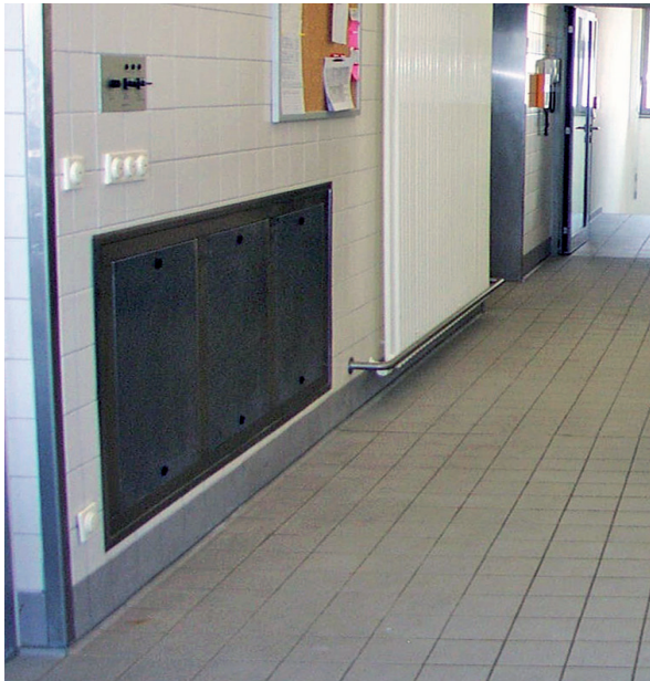
Abb. 15: Ein in der die Wand integrierter flacher Quellluftdurchlass (mit Spritz- bzw. Reinigungsrand).
