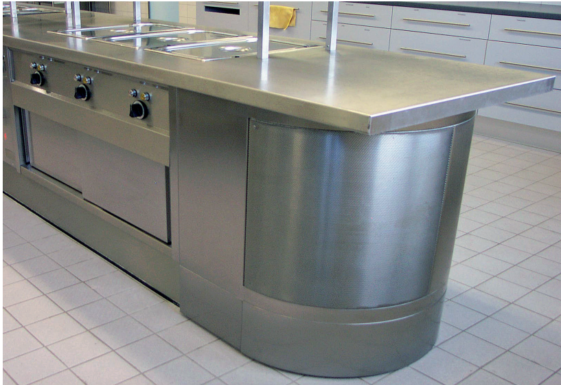
Abb. 16: In das Küchenmöbel integrierter halbzyklindrischer Quellluftdurchlass.
