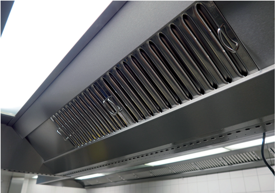
Abb. 20: Aerosolabscheider auch Flammenschutzfilter genannt
