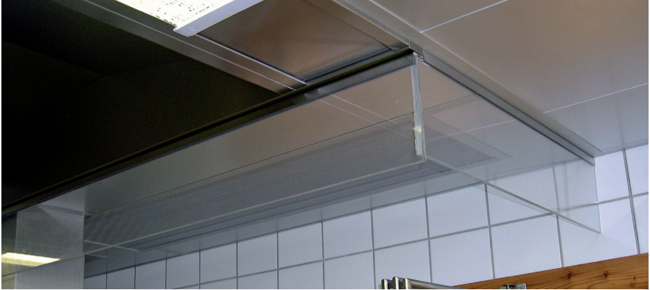
Abb. 19: Verdrängungsluftdurchlass mit Schürze
