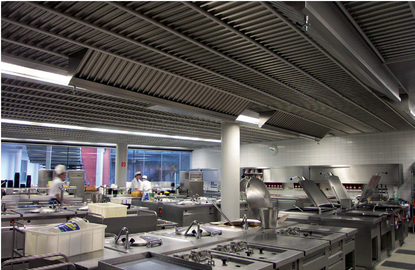
Abb. 7: Küchenlüftungsdecke
