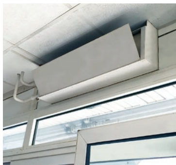
Beheizte Zuluftanlage (Innen- und Außenansicht)
