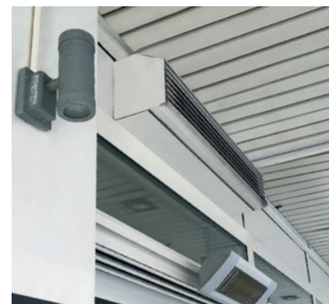
Beheizte Zuluftanlage (Innen- und Außenansicht)
