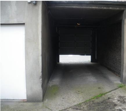
Abb. 1: Vom Fahrzeug aus mittels Fernbedienung bedienbares Rolltor
