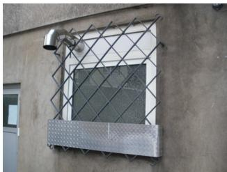
Abb. 7: Durch Gitter geschütztes Fenster
